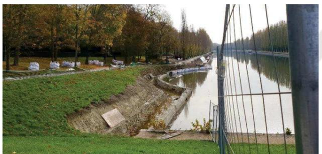
Travail de romain sur les perrés côté est, où sont prévus les caniveaux à grenouilles.
