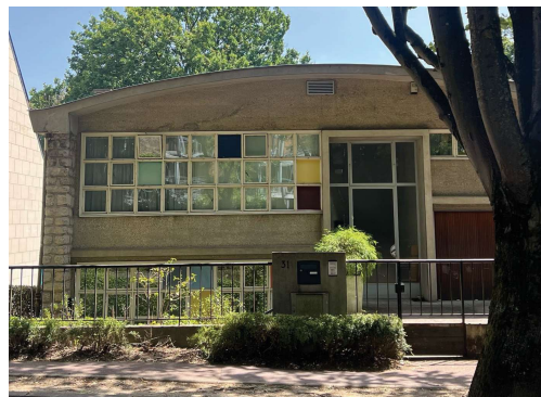
La maison Badin de l'architecte Paul Nelson
